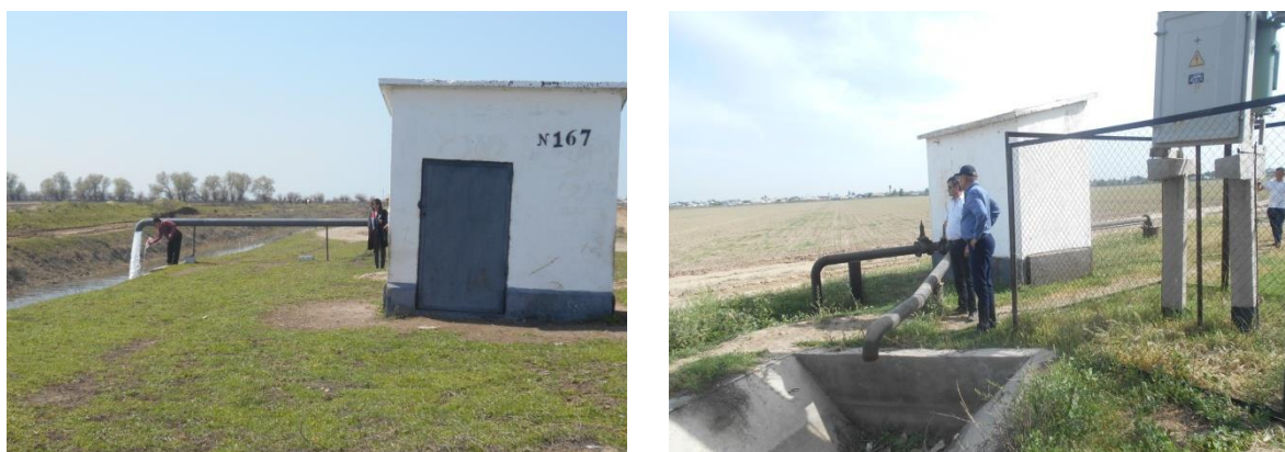
Рис. 1. Скважины вертикального дренажа
