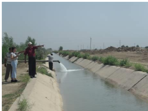
Рис. 2. Использование грунтовых воды для полива с помощью простой насосной установки и процесс смешивания грунтовой воды из скважины вертикального дренажа непосредственно с водой канала
