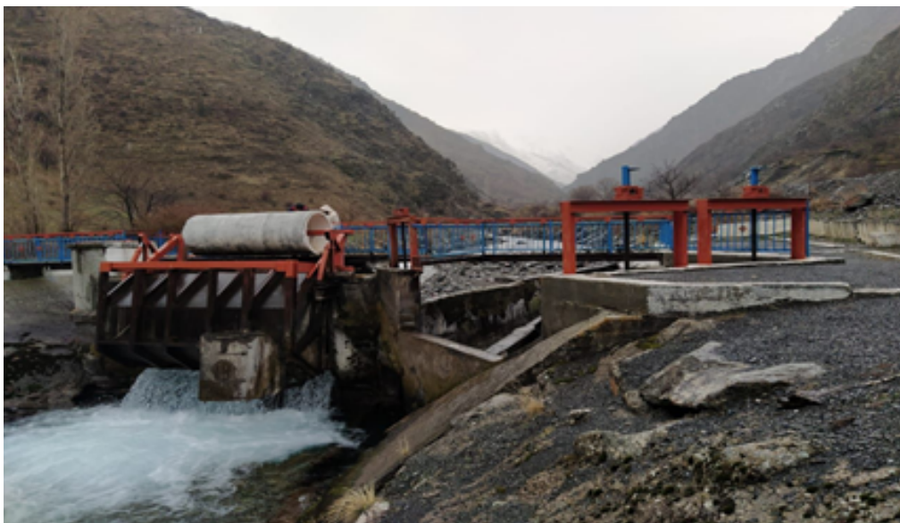
Рис. 1. Водозаборные сооружения предгорной зоны Московского района
